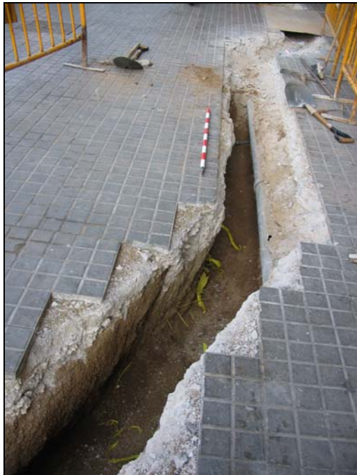
FOT. 1: Rasa 1 amb el rebaix finalitzat. FOT. 2: Final Rasa 1 abans de creuar el carrer Nou de la Rambla.
